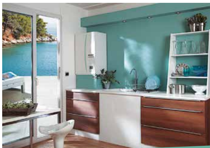
Primer montaže stenske vodne enote HIDROBOX v kuhinji.
